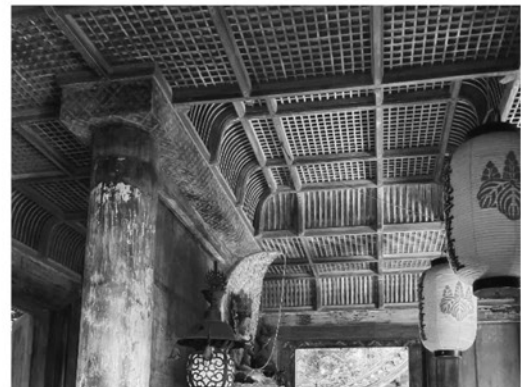
写真 16 円柱に残るヤリガンナ痕 日龍峯寺多宝塔内部（関市下之保）
