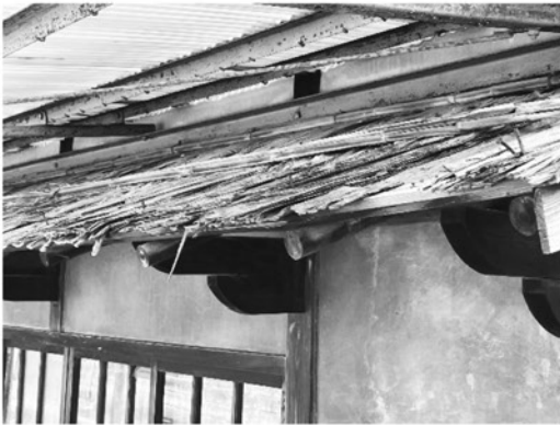
写真3 樽板製のひさし（上面）
