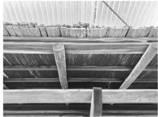
写真4 樽板製のひさし（下面） ※ともに、加茂郡七宗町神淵の民家
