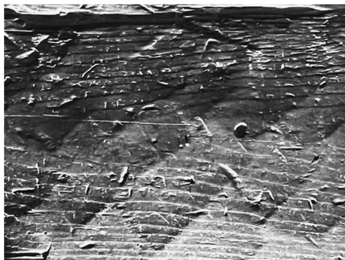
下呂市祖師野八幡宮幣殿の床板に残るチョウナ痕 (2024.5)
