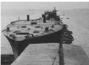
・図5 宇部港沈船防波堤の様子 使われた軍艦の形がはっきりとわかる 資料：宇部港直接作業船の歴史
