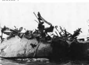
・図6 秋田港の沈船防波堤引き上げの様子 資料：東北地方整備局港湾航空部 軍艦が防波堤になりました。
